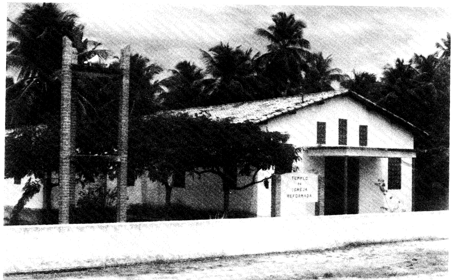
Templo da Igreja Reformada in São José da Coroa Grande.
